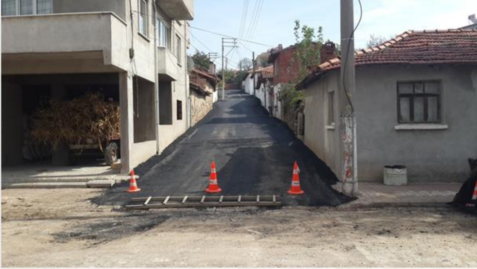
YENİCE MAHALLE DÜZGÜNYOL ÇIKMAZI ASFALT YAPILMASI
