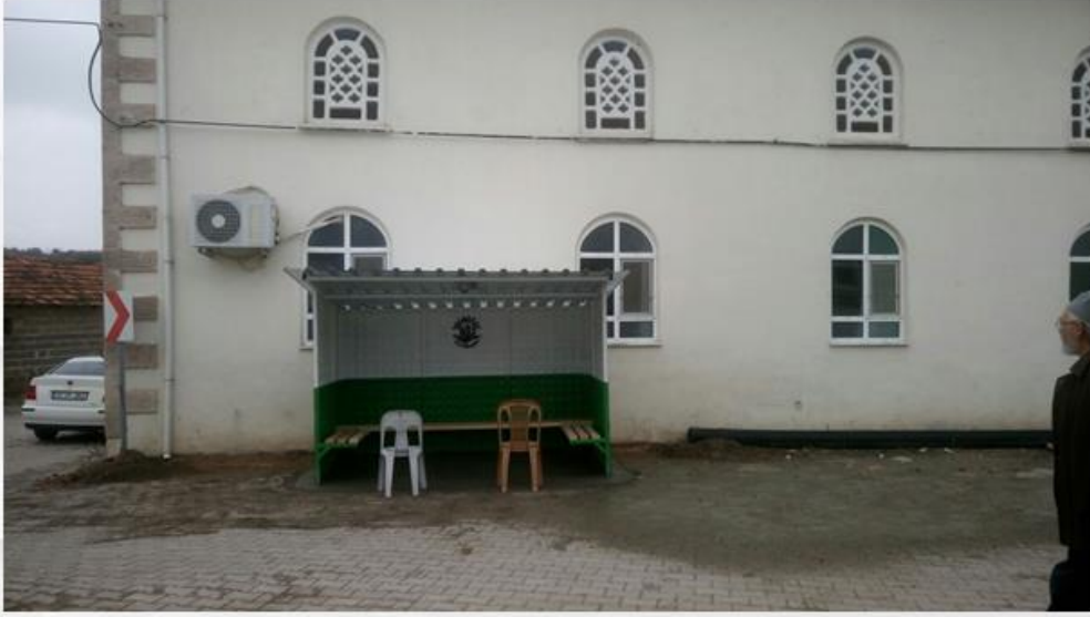
KALBURCU MAHALLESİ YOLCU BEKLEME DURAĞI YAPIMI
