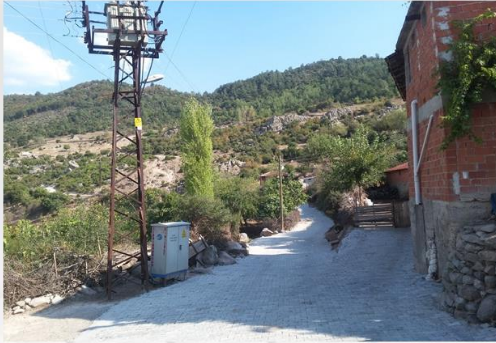
AHMETÖLEN MAHALLESİ KÖY İÇİ YOL DÜZENLEME
