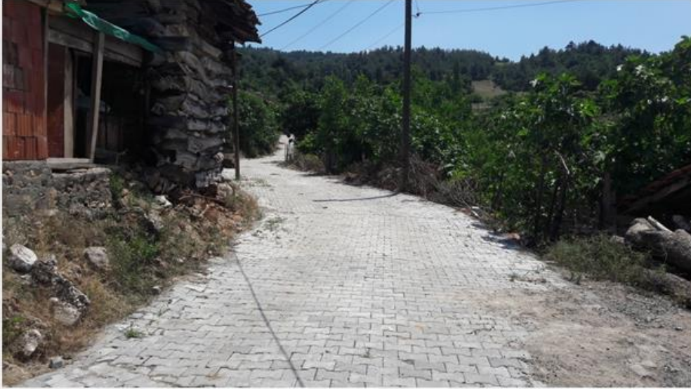
KAYALİ MAHALLESİ KÖY İÇİ YOL DÜZENLEME
