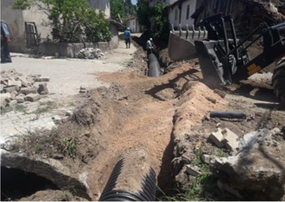
BÜKDERE MAHALLESİ YAĞMUR SUYU ŞEBEKE HATTI DÖŞENMESİ
