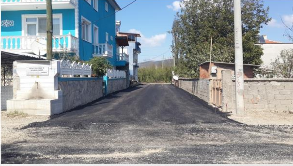
ASFALT VE YOL DÜZENLEME
