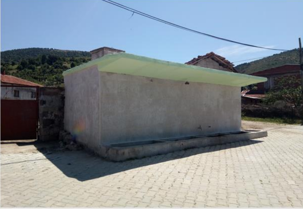
YAĞMUR SUYU MENFEZ , MAZGAL YAPIM İŞLERİ
