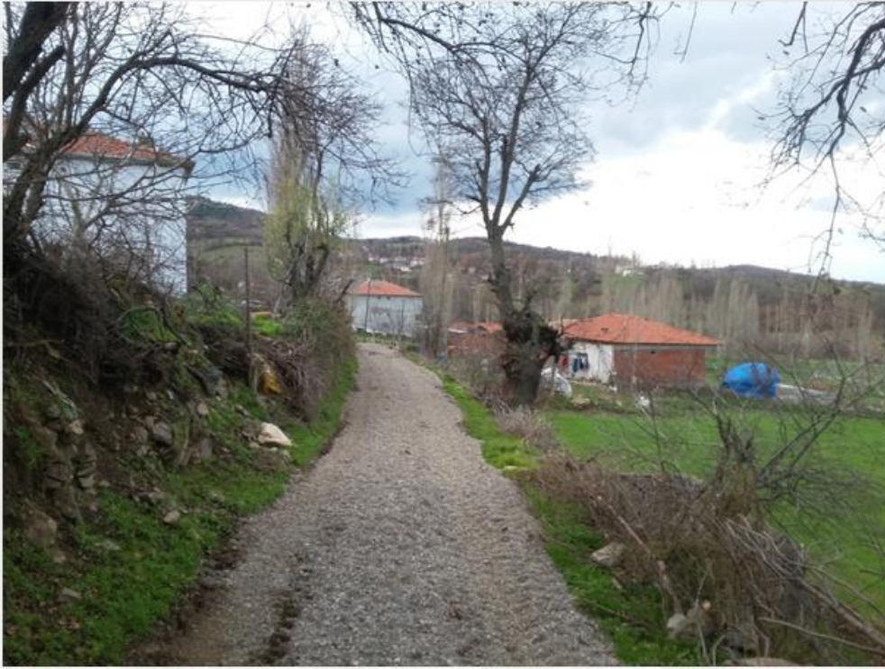
PİYADE MAHALLESİ KÖY İÇİ SİTABİLİZE YOL DÜZENLEME
