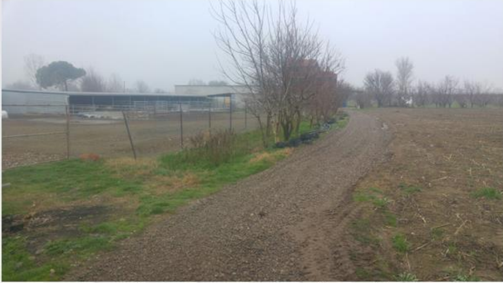
KASAPZADE MAHALLESİ ESKİ ŞEREMETLER YOLU SİTABİLİZE YOL DÜZENLEME
