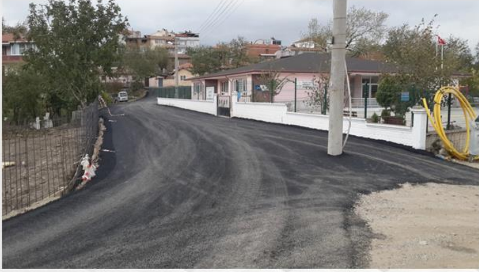
YENİCE MAHALLE ÇIĞDEM SOKAK ASFALT YAPILMASI
