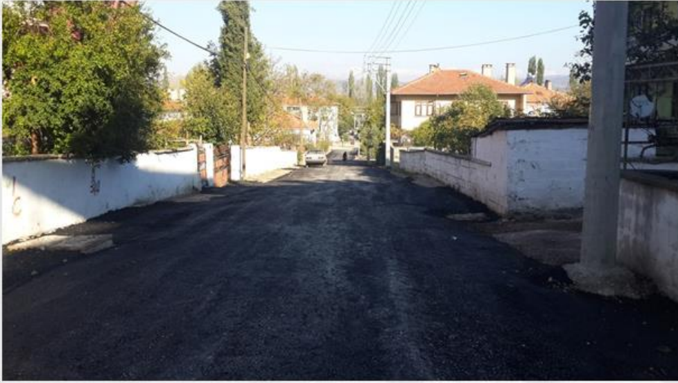
YENİCE MAHALLE ASLAN SOKAK ASFALT YAPILMASI
