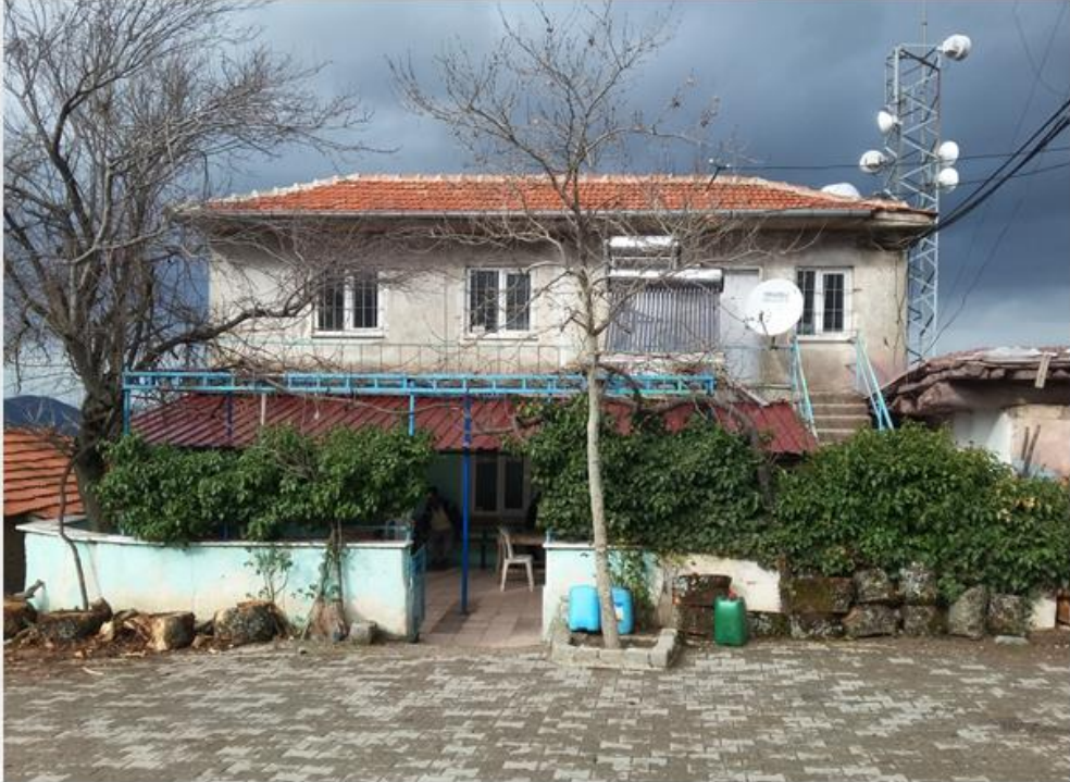
YOĞUNOLUK MAHALLESİ KAHVEHANE ÖNÜNE GÖLGELİK YAPIMI
