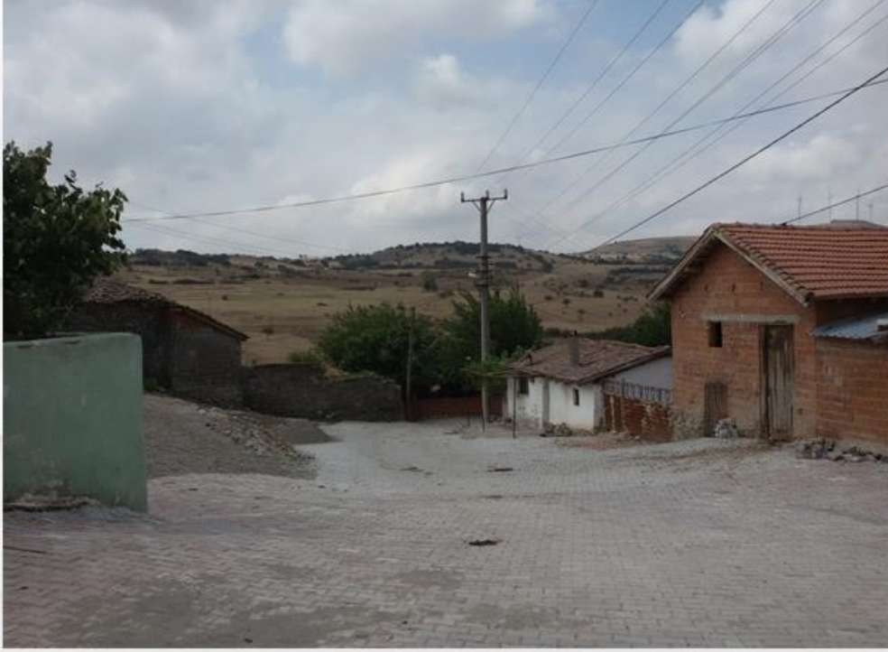
KARACAÖREN MAHALLESİ KÖY İÇİ YOL DÜZENLEME
