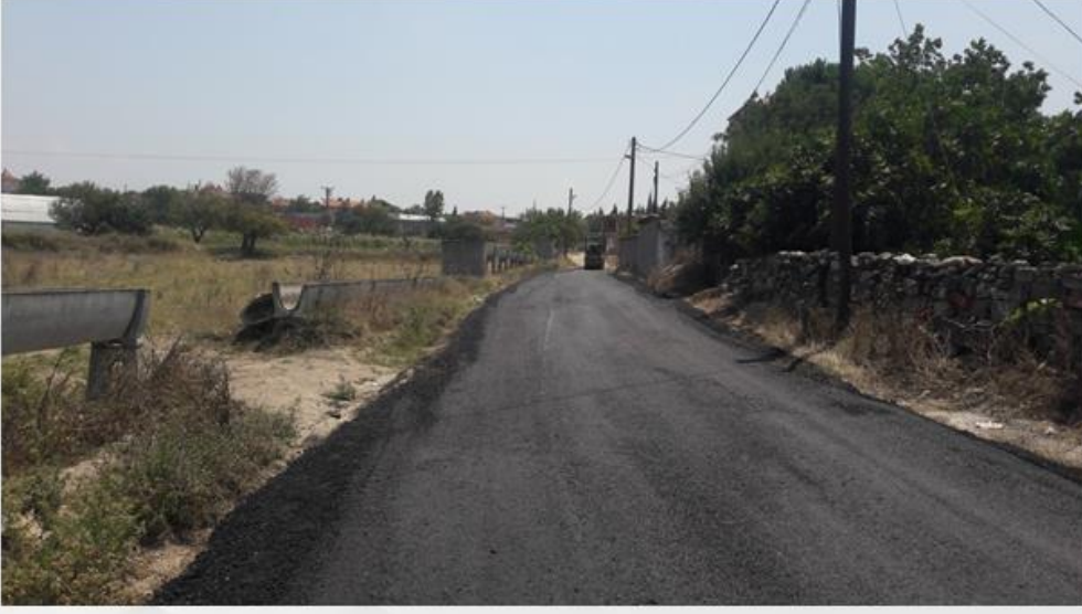
HOTAŞLAR MAHALLESİ KÖY İÇİ ASFALT YOL YAPILMASI
