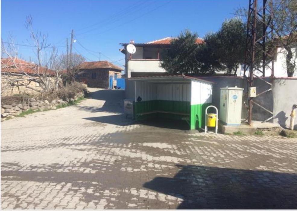
KARAAĞAÇ MAHALLESİ YOLCU BEKLEME DURAĞI YAPIMI
