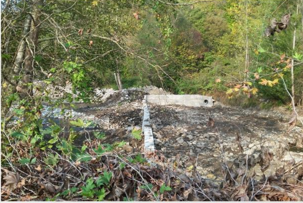
DERELİ MAHALLESİ ARAZİ SULAMASI İÇİN BENT YAPIMI
