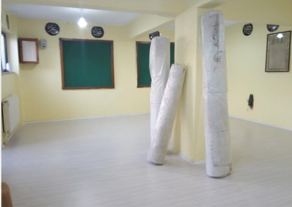
KASAPZADE MAHALLESİ ÇINARALTI CAMİİ BAYAN MESCİDİ ŞAP VE LAMİNANT VE TADİLAT YAPIMI
