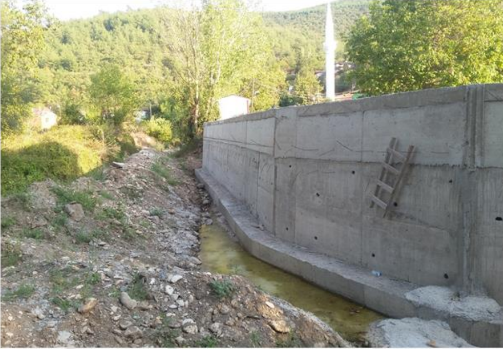
DERELİ MAHALLESİ ÇOK AMAÇLI SALON YAPIMI İSTİNAT DUVARININ YAPIMI
