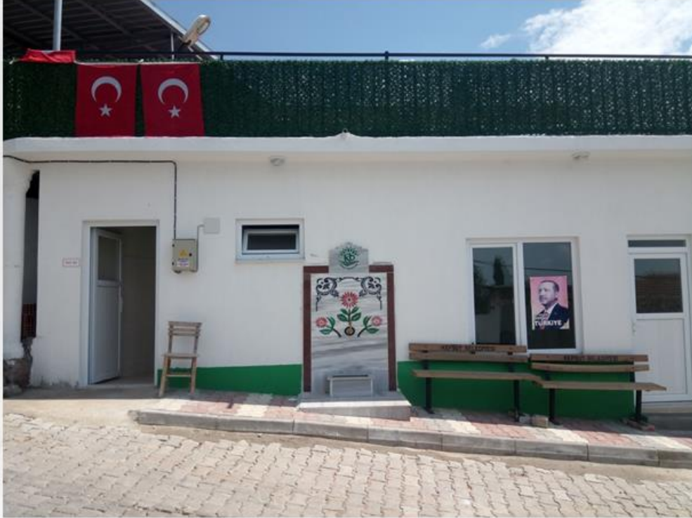
DURAK MAHALLESİ KÖY İÇİ ÇEŞME YAPILMASI
