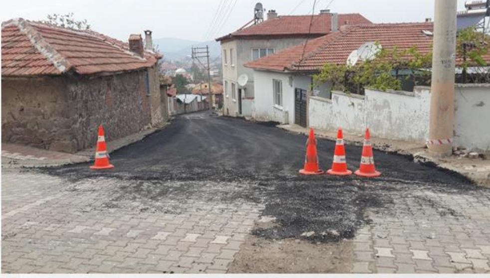
ASFALT VE YOL DÜZENLEME
