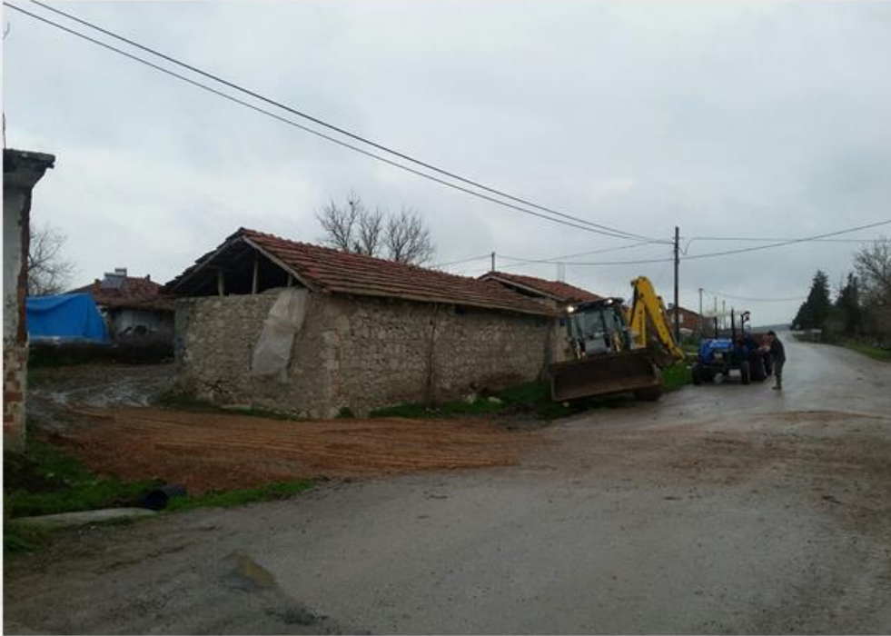
OSMANIYE MAHALLESİ YAĞMUR SUYU MENFEZİ YAPILMASI
