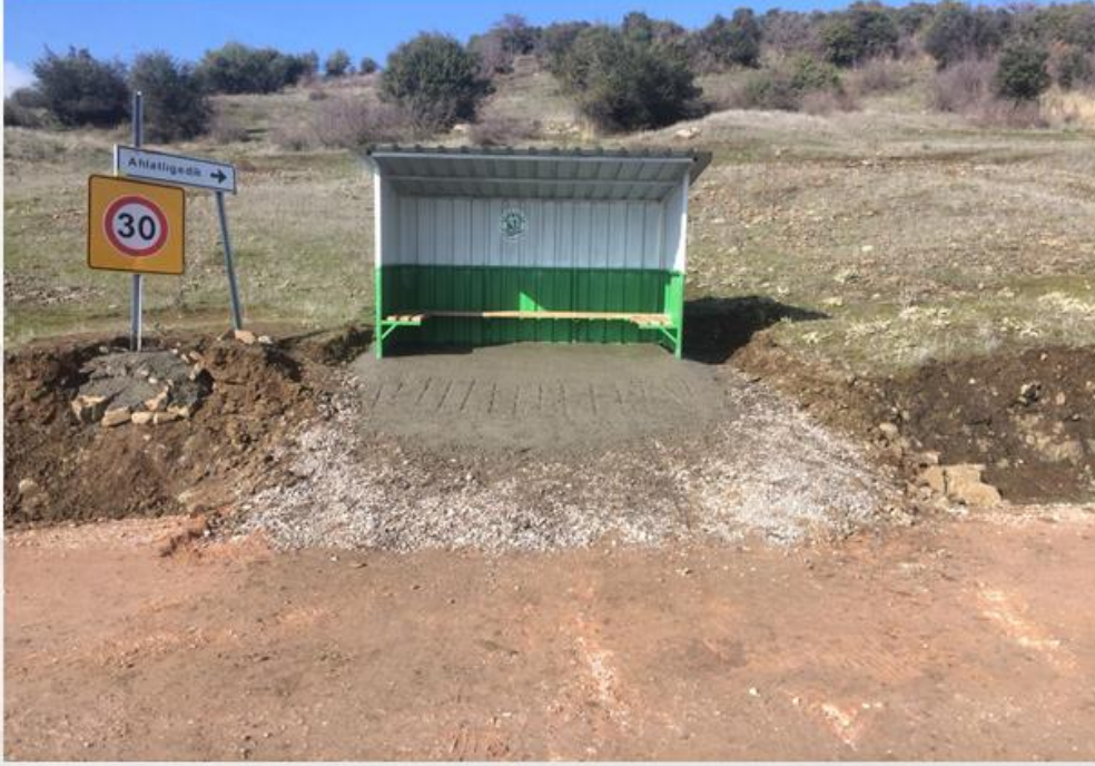
DANAHİSAR MAHALLESİ AHLATLI GEDİK YOLCU BEKLEME DURAĞI YAPIMI
