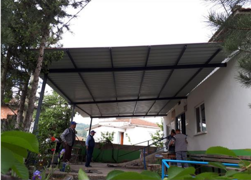
SEÇDERE MAHALLESİ KÖY KAHVEHANESİ GÖLGELİK YAPIMI
