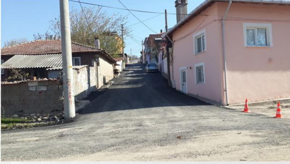
ASFALT VE YOL DÜZENLEME
