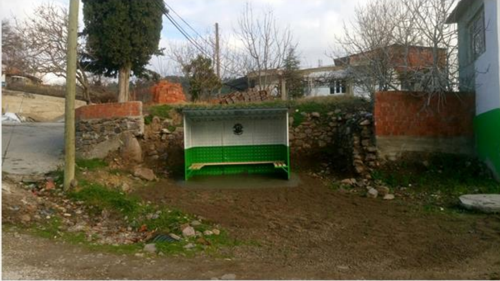
EYÜPBÜKÜ MAHALLESİ YOLCU BEKLEME DURAĞI YAPIMI
