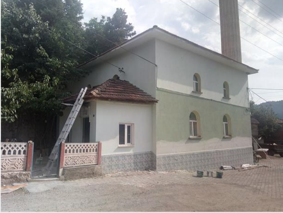
KÜÇÜK KATRANCI MAHALLESİ CAMİİ TADİLATI YAPIMI
