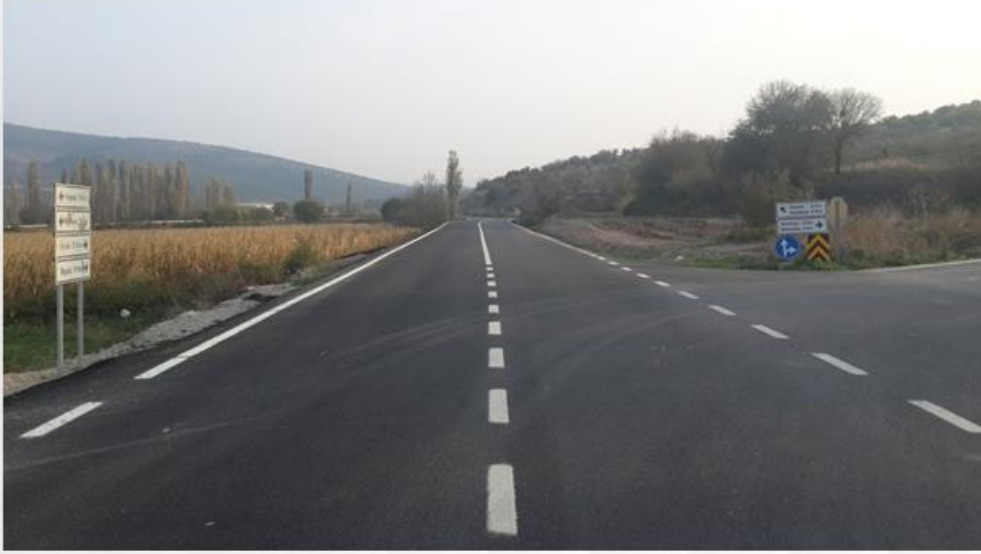
NUSRET MAHALLESİ ANA YOL ASFALT YAPILMASI
