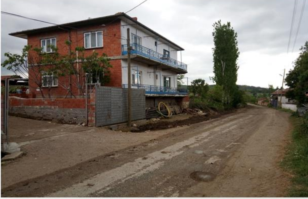
YAĞMUR SUYU MENFEZ , MAZGAL YAPIM İŞLERİ
