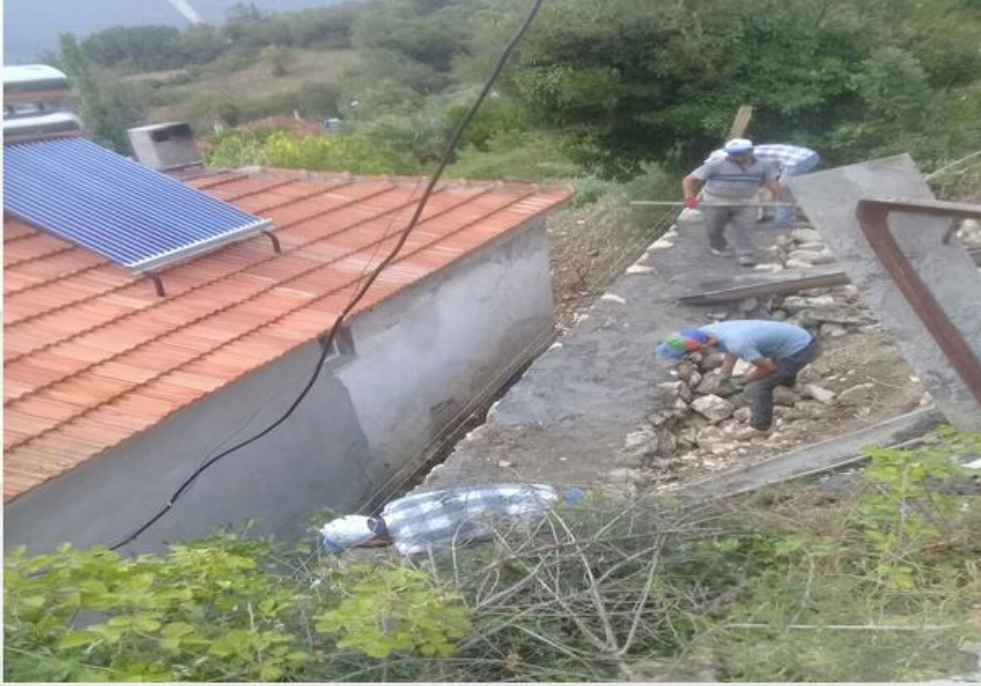
MEZİTLER MAHALLESİ İSTİNAT DUVARI YAPIMI
