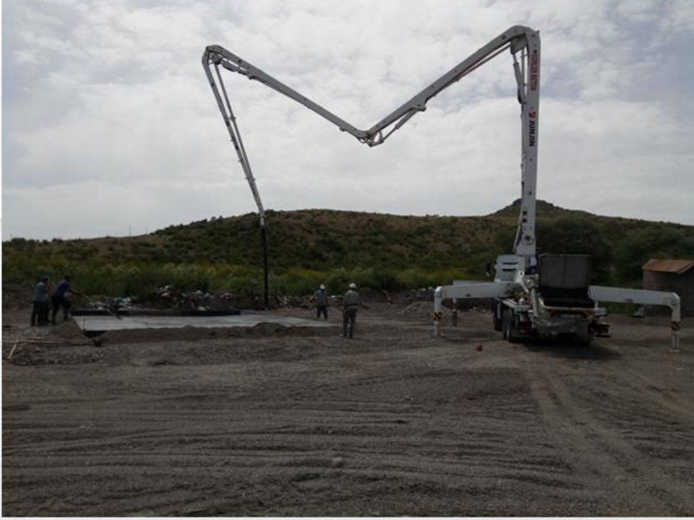
İHSANİYE MAHALLESİ KIRMA ELEME TESİSİ SAHA BETONU ATILMASI
