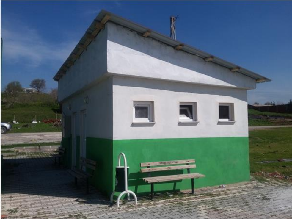
MAHMUDİYE MAHALLESİ HALI SAHA SOYUNMA ODASI ÇATI YAPIMI
