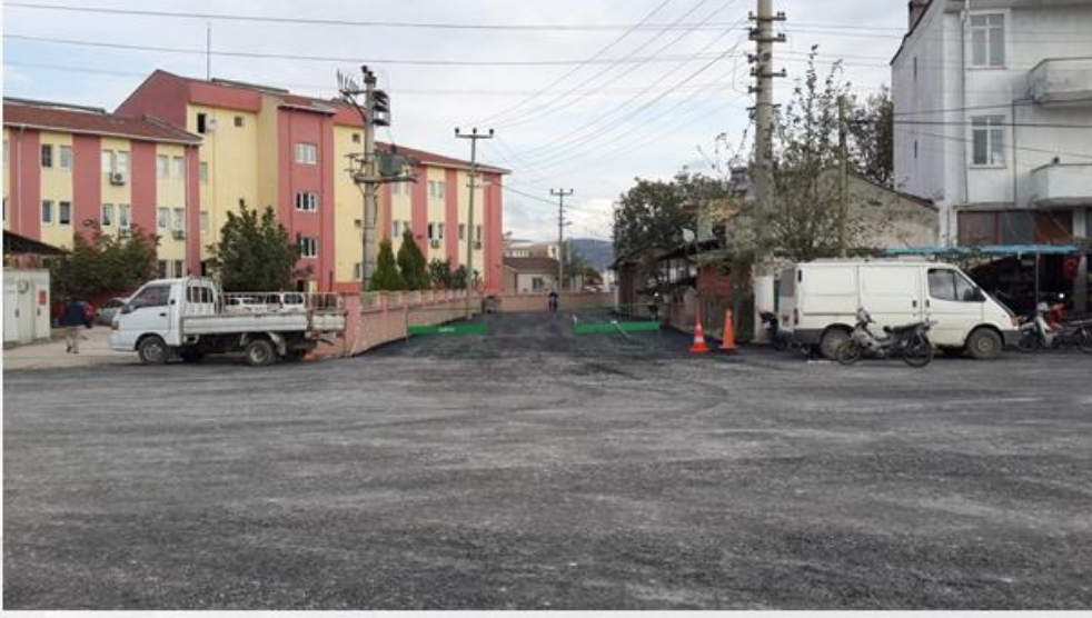
ASFALT VE YOL DÜZENLEME
