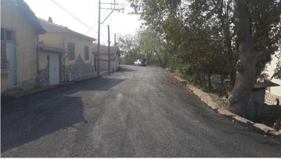
YENİCE MAHALLE KISA YOKUŞ SOKAK ASFALT YAPIMI
