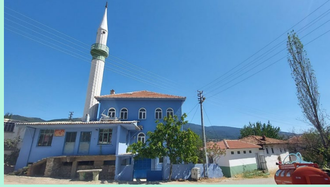
TUZAK MAHALLESİ CAMİ TADİLATI
