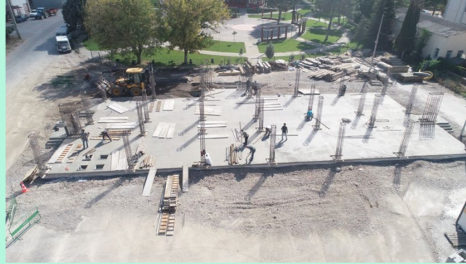
GENÇLİK MERKEZİ İNŞAATI YAPIMI
