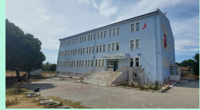
MAHMUDİYE MAHALLESİ OKULUNUN BOYANMASI
