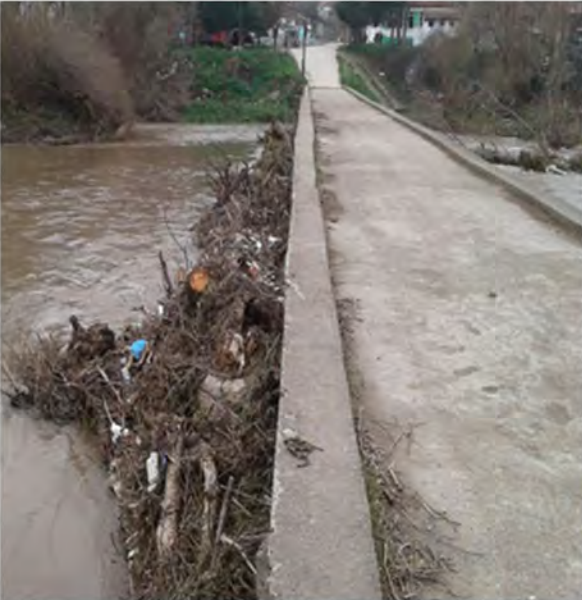
Bektaşlar Mahallesi Köprüsü;
