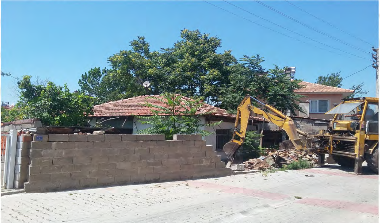
KASAPZADE MAHALLESİ TEHLİKELİ YAPI YIKILDI
