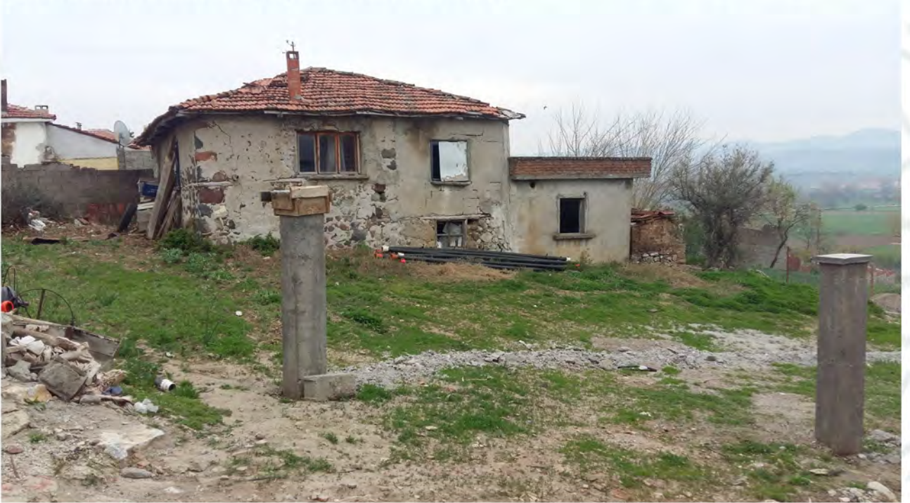
TEKKAİŞIKLAR MAHALLESİ TEHLİKELİ YAPI YIKILDI
