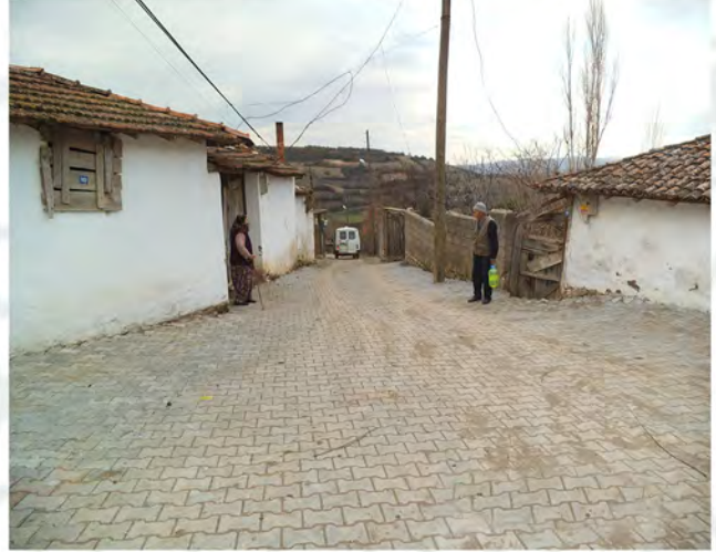
KEÇİDERE PARKE TAŞI DÖŞEME
