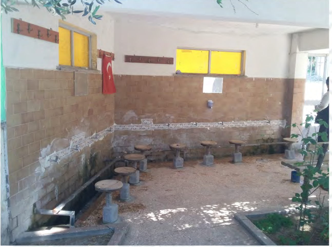
KALBURCU MAHALLESİ CAMİ ABDESTLİĞİ TAMİRATI YAPILDI
