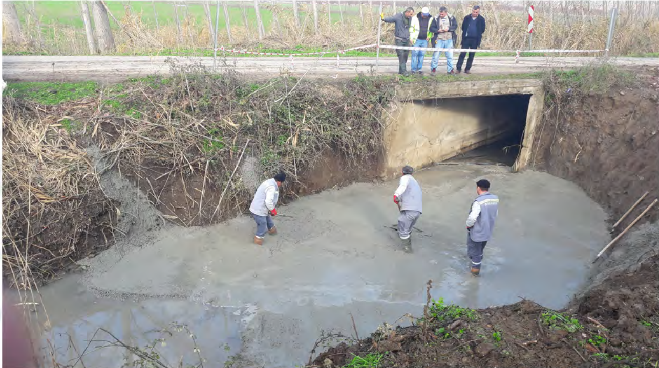
CAMİCEDİT MAHALLESİ ILICA KÖPRÜSÜ GENİŞTİLMESİ YAPILDI
