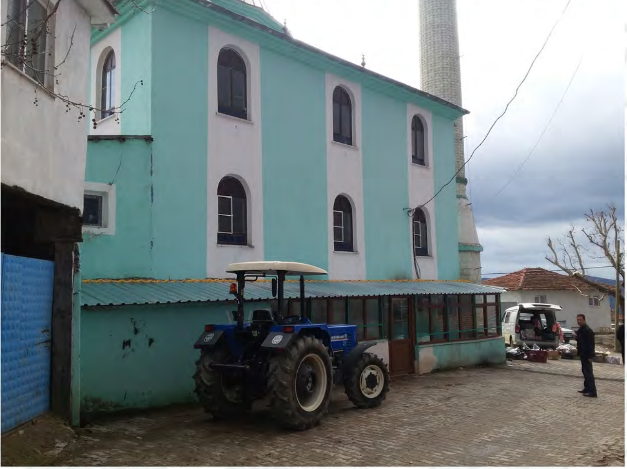
YOĞUNOLUK MAHALLESİ CAMİİ ETRAFINA ÇATI YAPILDI
