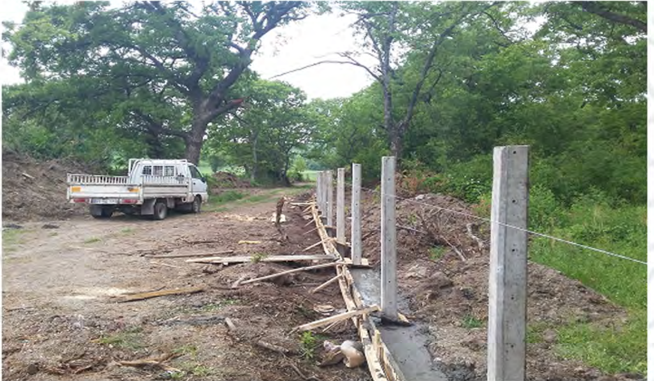
PIYADE MAHALLESİ 1.MEZARLIK ÇEVRESİNE TEL ÖRGÜ ÇEKİLMESİ
