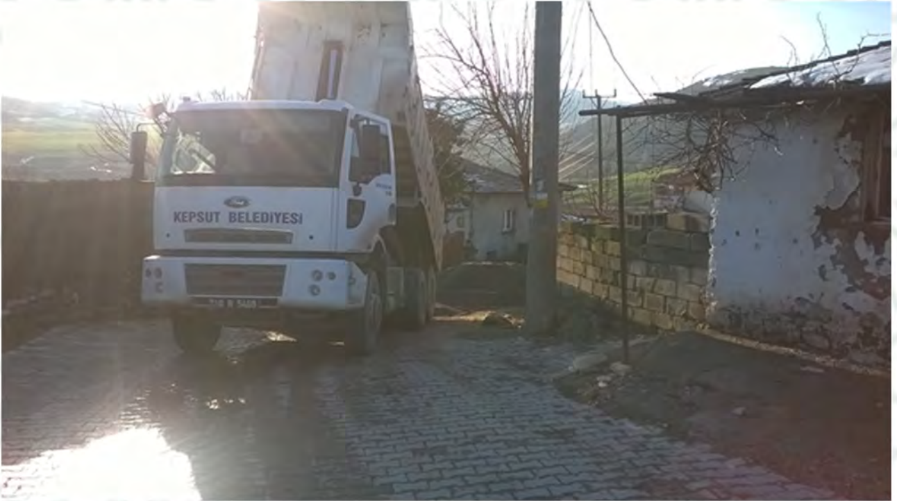
Karacaören mahallesi yol yapım bakım ve onarım çalışması
