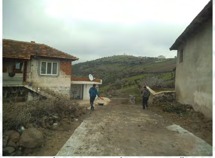
DANAHIŞAR MAHALLESİ PARKE TAŞI DÖŞEME
