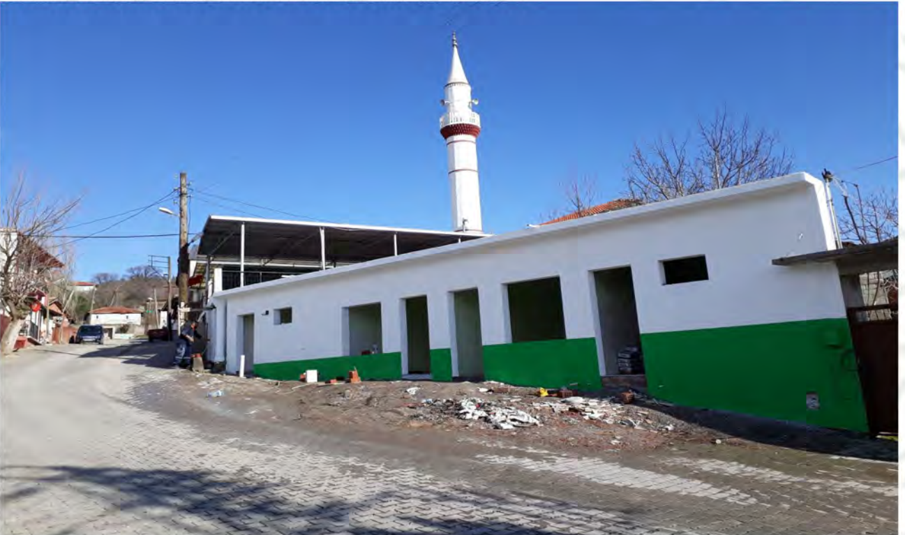
DURAK MAHALLESİ WC YAPIMI
