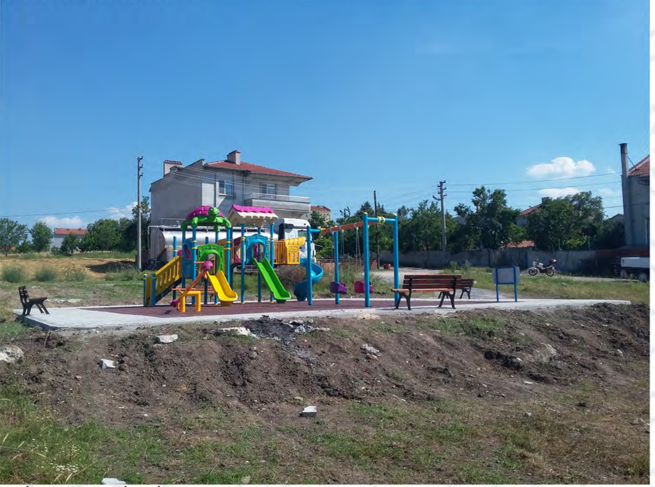
YENİCE MAHALLESİ ŞEHİT AYHAN YILMAZ PARKI ÇOCUK OYUN GURUBU YAPIMI
