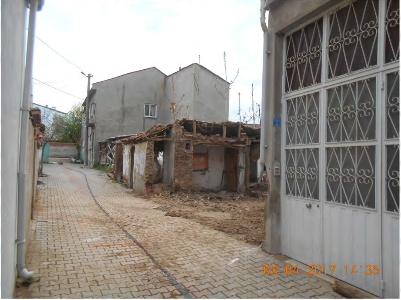
KASAPZADE MAHALLESİ TEHLİKELİ YAPI YIKILDI
