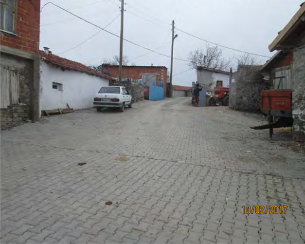
YOĞUNOLUK PARKE TAŞI DÖŞEME YAPILMASI
