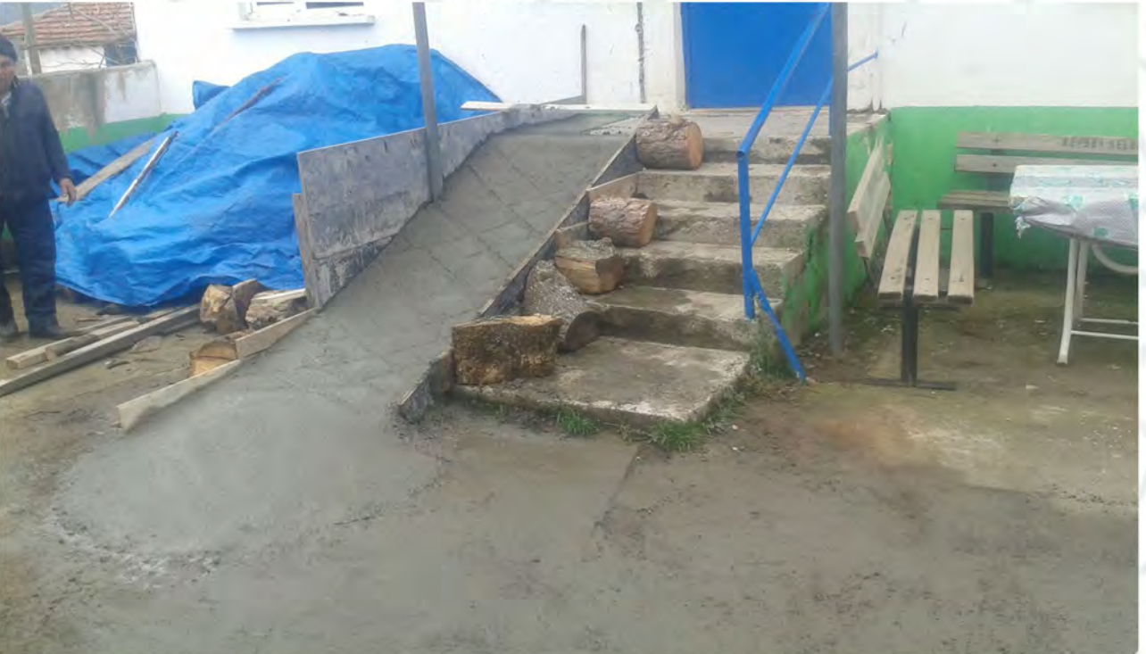
ŞEÇDERE MAHALLESİ KÖY KAHVESİ ENGELLİ GİRİŞİ YAPILDI
