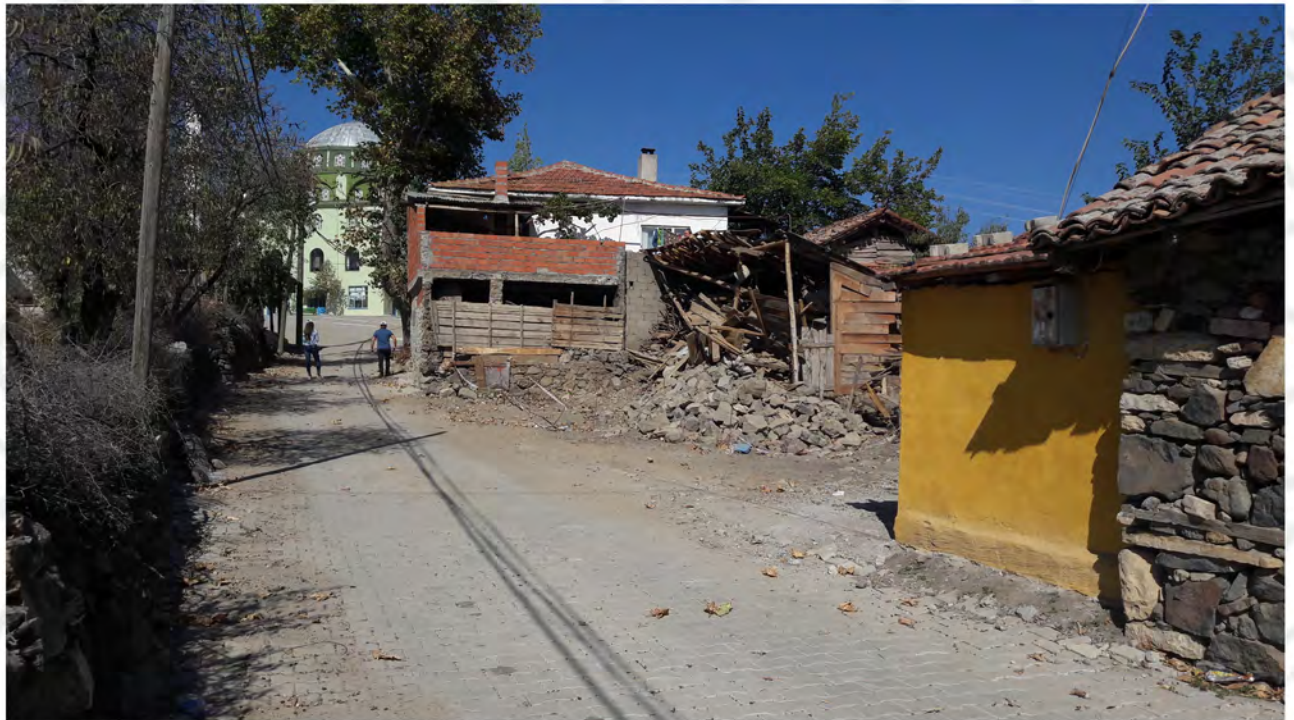
İSAALAN MAHALLESİ TEHLİKELİ YAPI YIKILDI
