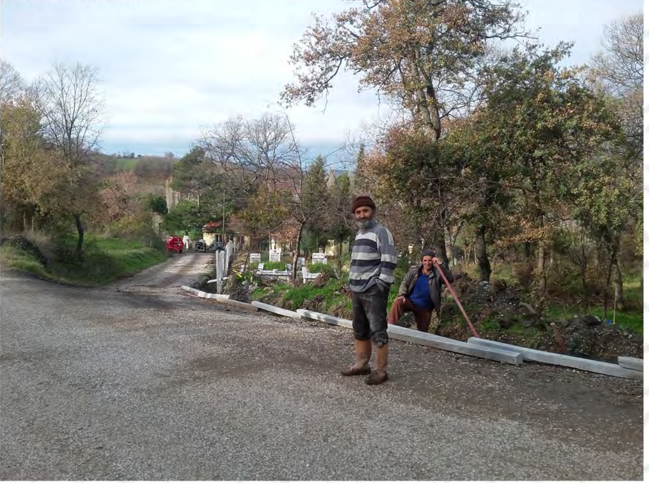
PIYADE MAHALLESİ 1.MEZARLIK ÇEVRESİNE TEL ÖRGÜ ÇEKİLMESİ
