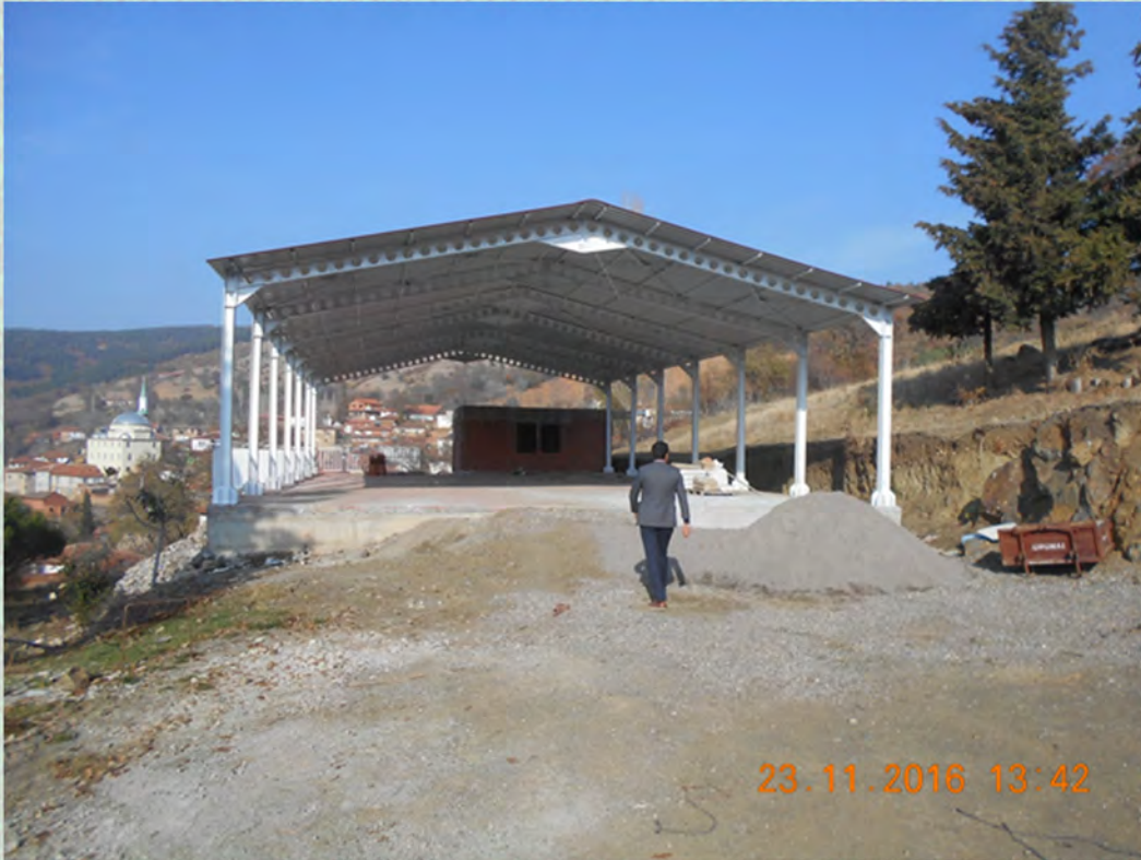
ÖRENHARMAN MAHALLESİ ÇOK AMAÇLI TESİS
