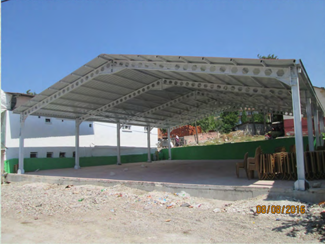
AKÇAKÖY MAHALLESİ ÇOK AMAÇLI TESİS
