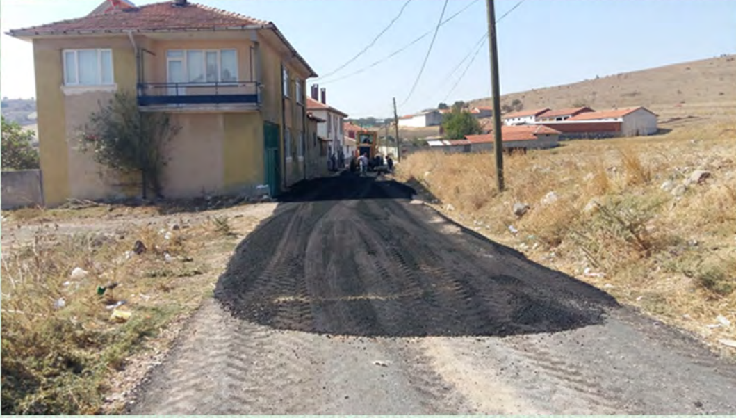
SARAÇ MAHALLESİ KÖY İÇİ YOLU
