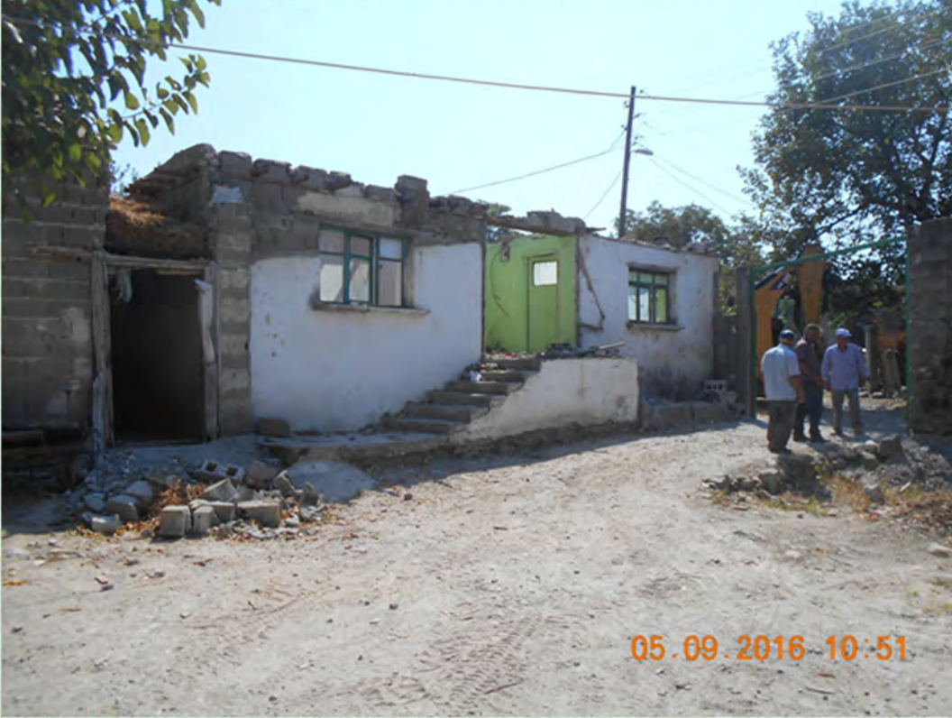
BEYKÖY MAHALLESİ TEHLİKELİ YAPI YIKILDI
