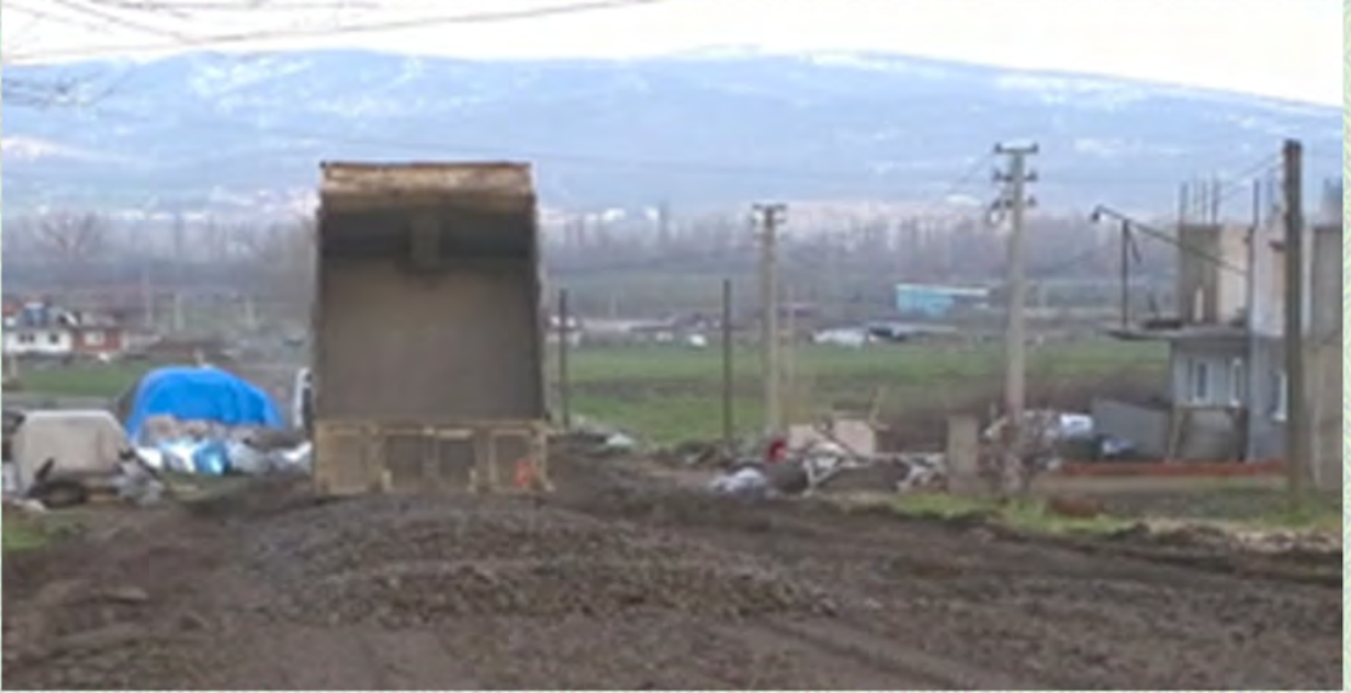
Yenice mahalle yol yapım bakım ve onarım çalışması
