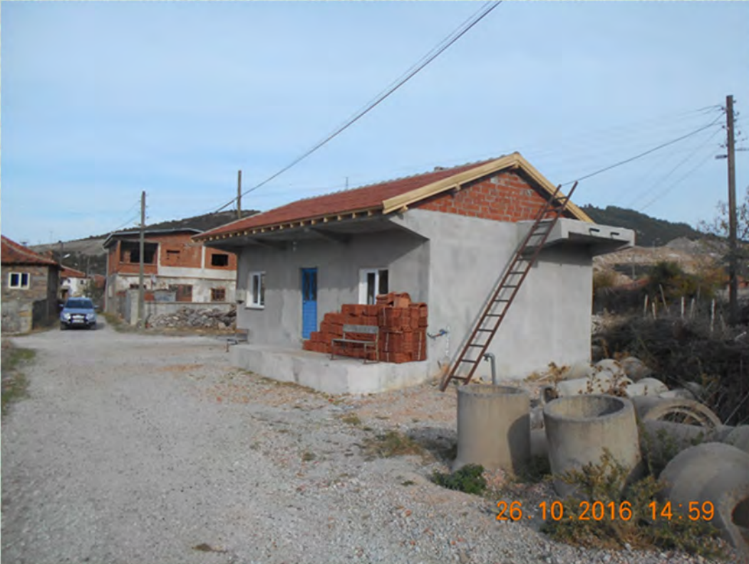
KARACAAĞAÇ MAHALLESİ KAHVEHANE ÇATI YAPIMI
