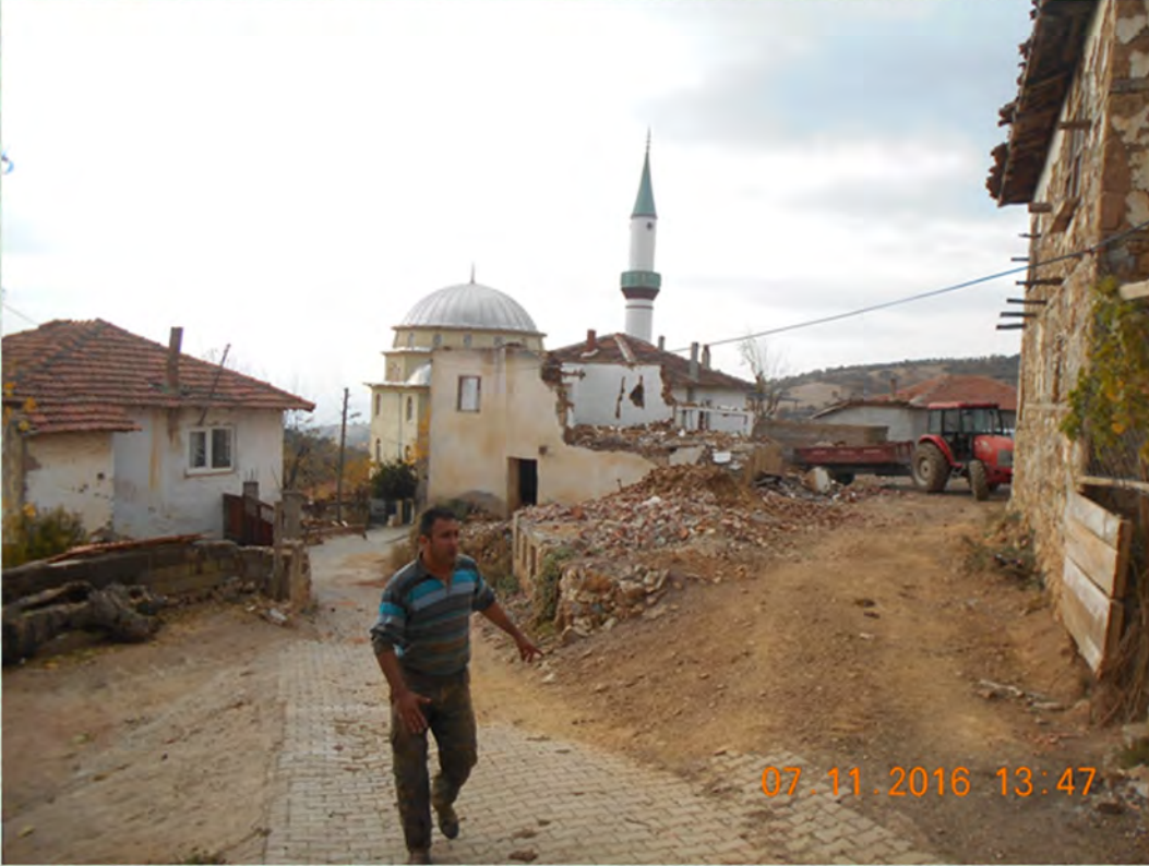
ÖRENHARMAN MAHALLESİ TEHLİKELİ YAPI YIKILDI
