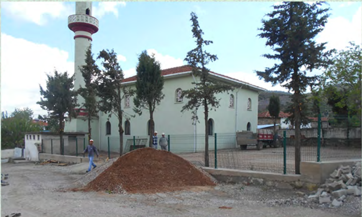
KARACAAĞAÇ MAHALLESİ CAMİİ ÇEVRESİ DUVAR YAPIMI
