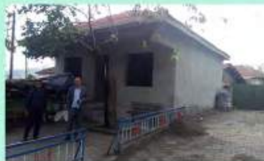
İSAALAN MAHALLE MUHTARLIĞI İNŞAAT HALİ
