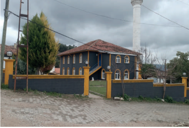
IŞIKLAR MAHALLESİ KÖY CAMİSİ TAMİRAT ÇALIŞMASI
