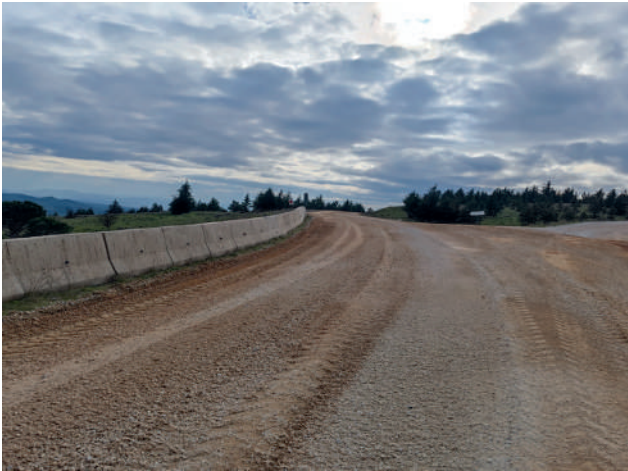
EŞELER MAHALLESİ STABİLİZE MALZEME ÇEKİLMESİ YOL DÜZENLEMESİ
