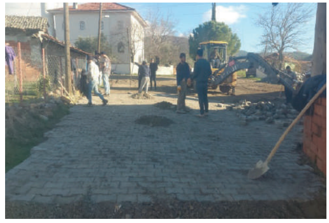
KARAHALLER MAHALLESİ KİLİTLİ PARKE TAŞ DÖŞEME
