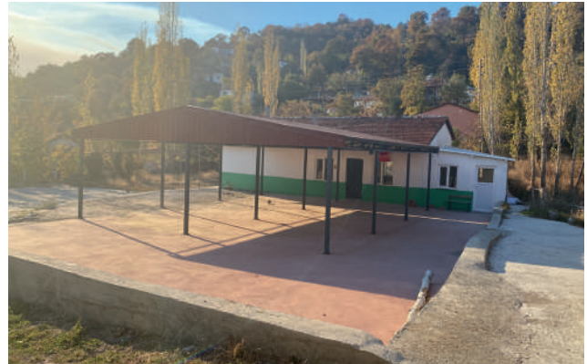
TUZAK MAHALLESİ ÇOK AMAÇLI TESİS YAPIMI
