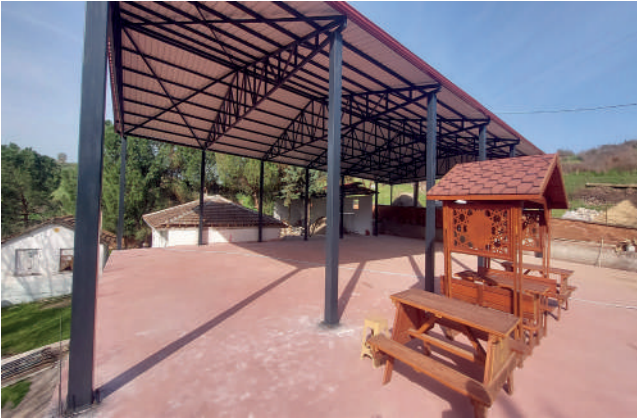
DEDEKAŞI MAHALLESİ ÇOK AMAÇLI TESİS YAPIMI
