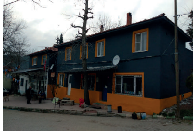
GÖKKÖY MAHALLESİ KÖY KONAĞI BOYANMASI
