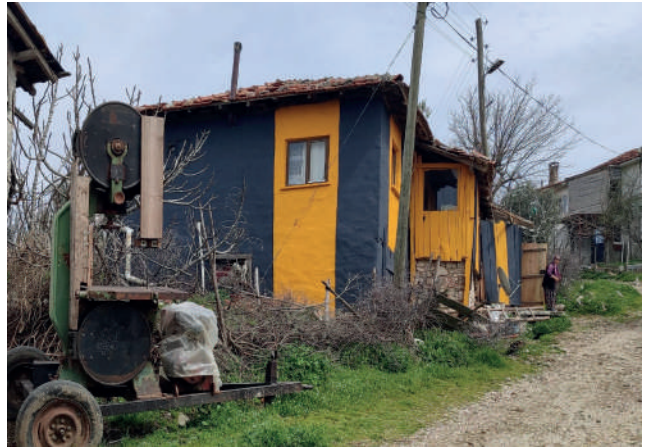
KAYACIKLAR MAHALLESİ KÖY KÖY KONAĞI BOYANMASI
