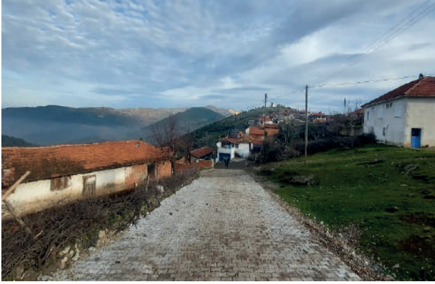
ARAPLAR MAHALLESİ KİLİTLİ PARKE TAŞ DÖŞEME
