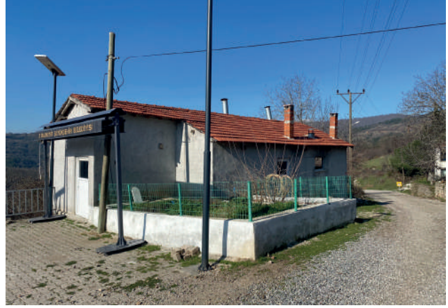
KAYAEİLİ MAHALLESİ AŞ EVİ YAPIMI
