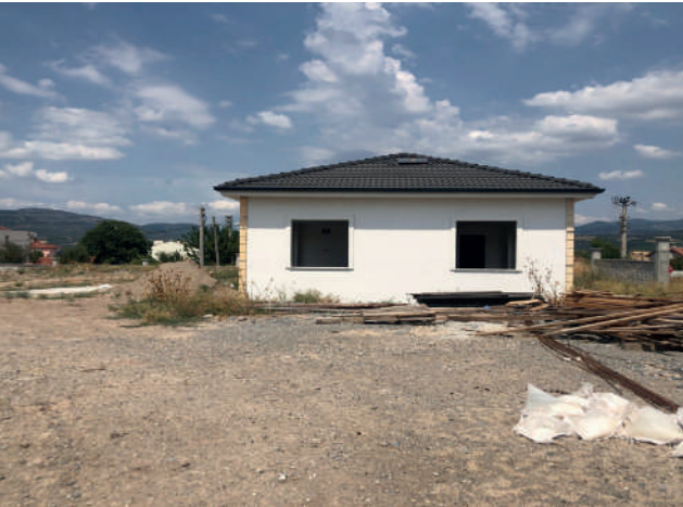
YENİCE MAHALLESİ ÇOK AMAÇLI TESİS YAPIMI
