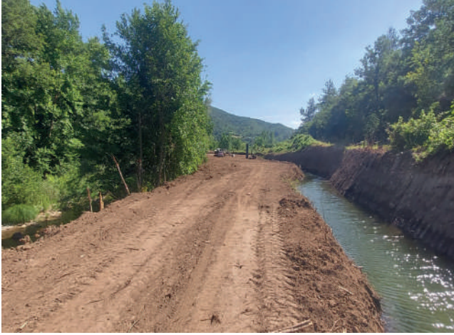
DERELİ MAHALLESİ SU KANALI YAPIM ÇALIŞMASI
