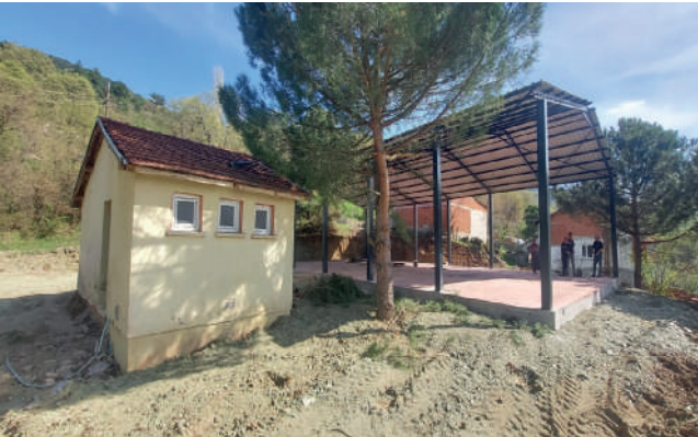
PİYADE MAHALLESİ ÇOK AMAÇLI TESİS YAPIMI
