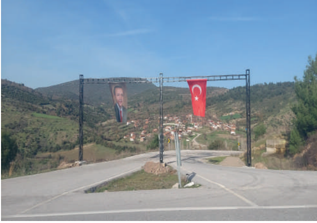
EYÜPBÜKÜ MAHALLESİ GİRİŞ TAK MONTAJ ÇALIŞMASI
