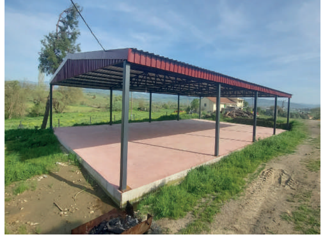
RECEP MAHALLESİ ÇOK AMAÇLI TESİS YAPIMI
